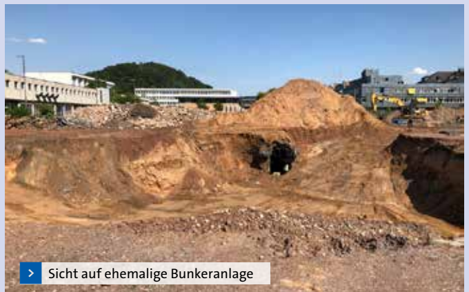
> LPP N. Rupp und IM K. Bouillon auf der Baustelle der neuen Groß-PI
