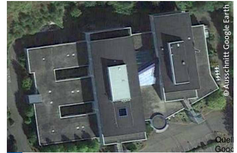
Gebäude des geplanten Polizeiareals in Kirkel
